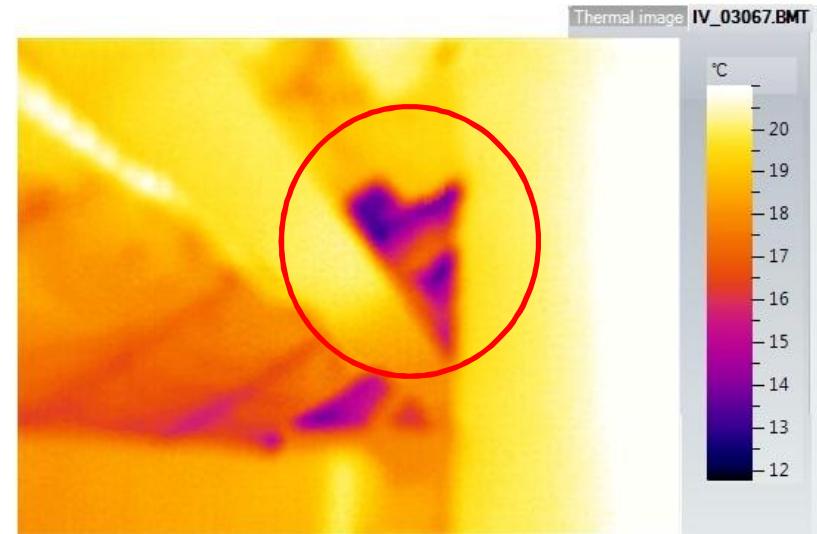
Isolatie gebrek op zolder
