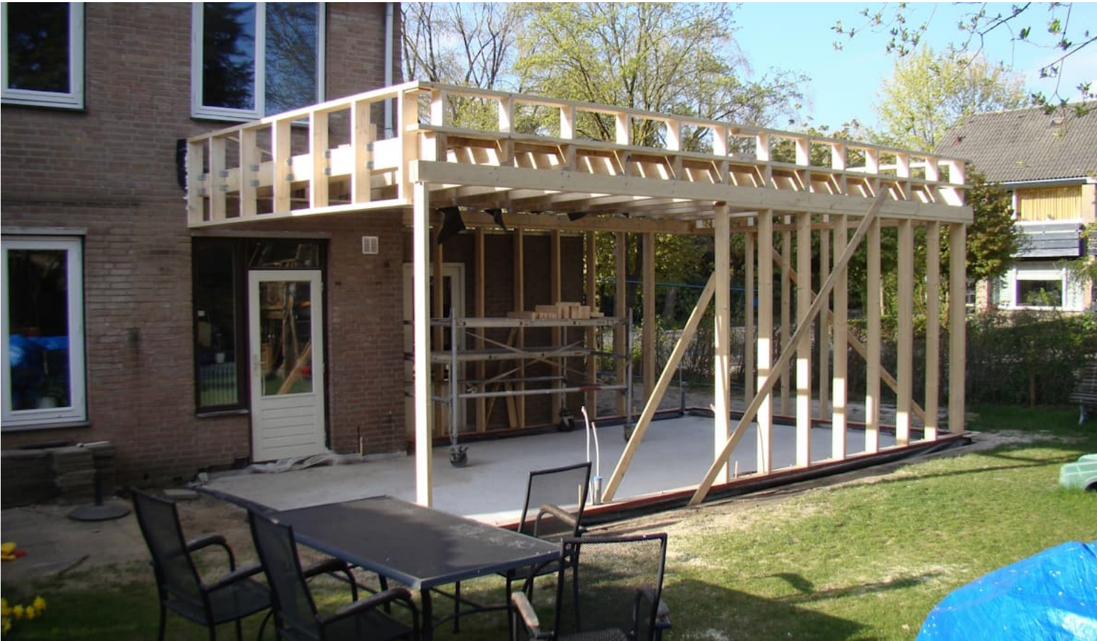
Aanbouw in 2013, houtskelet, biobased, sedumdak
