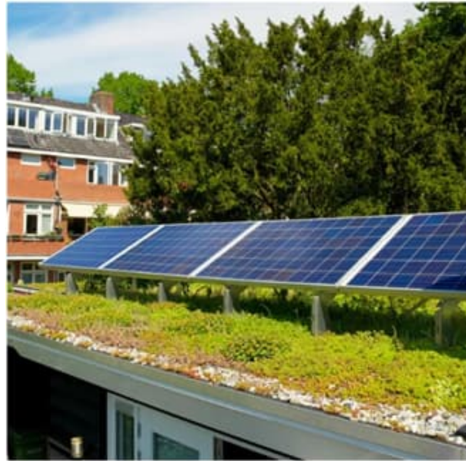
Sedumdak onder zonnepanelen
