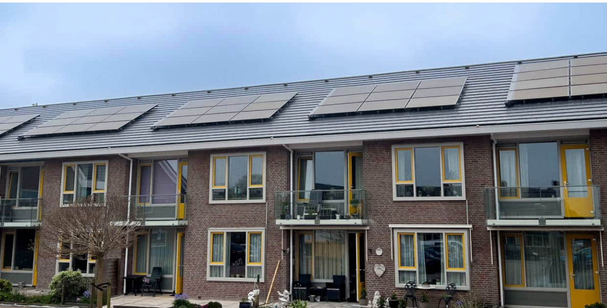
‘t Snijdersveld in Obdam 44 appartementen 44 PVT-warmtepompen, 44 warmwaterboilers en 216 PVT-panelen.
