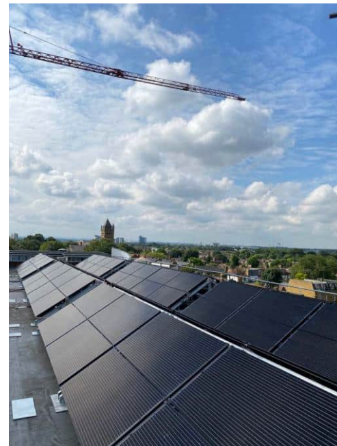
De grootste PVT-installatie | Universiteit van West-Londen 580 PVT-panelen. Energiebesparing van +500 ton CO2 per jaar.
