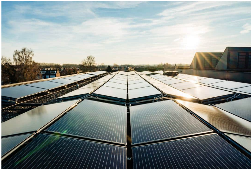
de Tuinen in Woudenberg - woon-zorgcombinatie WKO regeneratiedak met 340 PVT panelen
