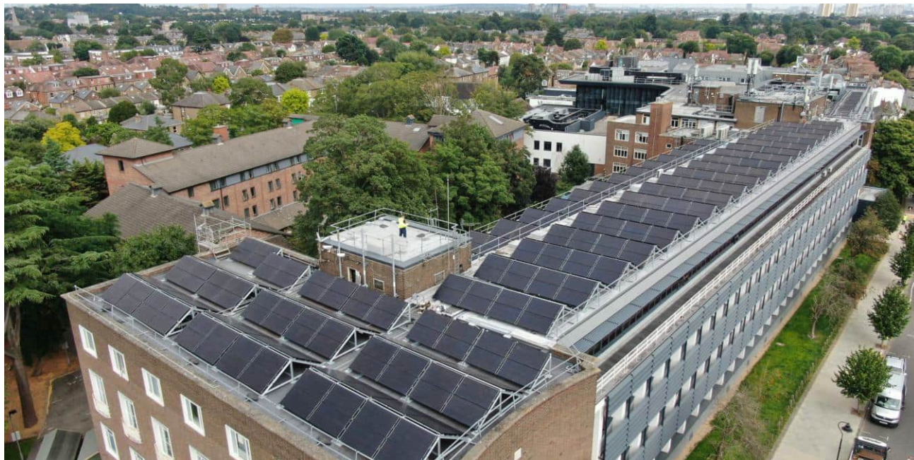
De grootste PVT-installatie | Universiteit van West-Londen 580 PVT-panelen. Energiebesparing van +500 ton CO2 per jaar.
